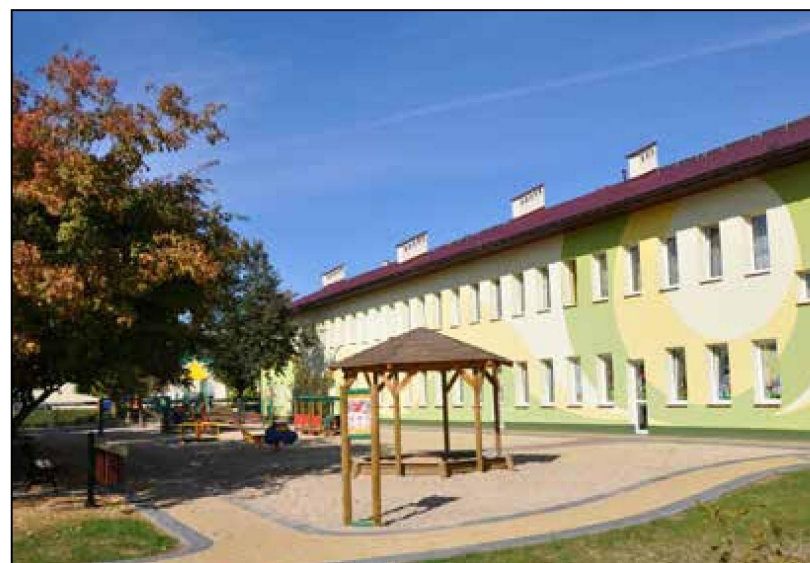
Publiczne Przedszkole w Połańcu, ul. Madalińskiego 1 Projekt przewiduje 80 szt. paneli o mocy maksymalnej 275W każdy (razem 22 000 W)
